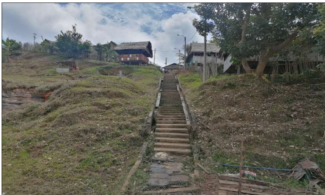
FIGURA N°02: EROSIÓN DEL TALUD DEL CAUCE DEL RÍO NAPO, SE PUEDE APRECIAR LA ESCALINATA AFECTADA POR LA FUERZA DEL
